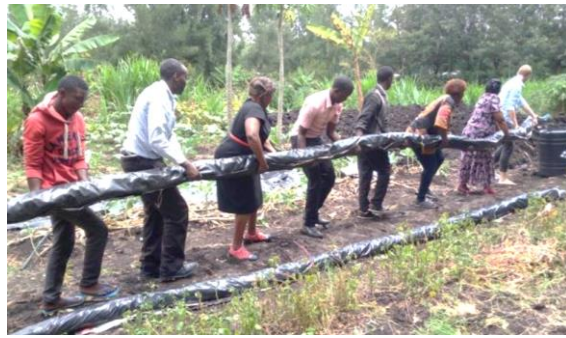
Die fertig montierte Bewässerungsleitung wird verlegt. Foto: Zahl
