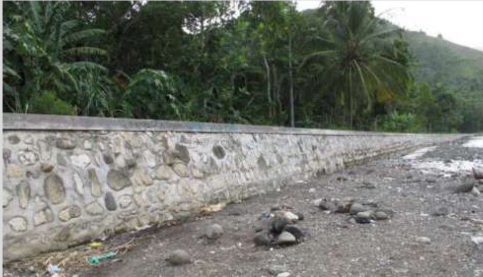
Von der WHH gebaute Hochwasserschutzmauer im Süden Haitis
